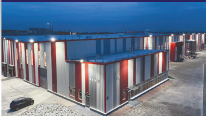
ПРОИЗВОДСТВЕННЫЕ ПОМЕЩЕНИЯ, СКЛАДЫ И АНГАРЫ
